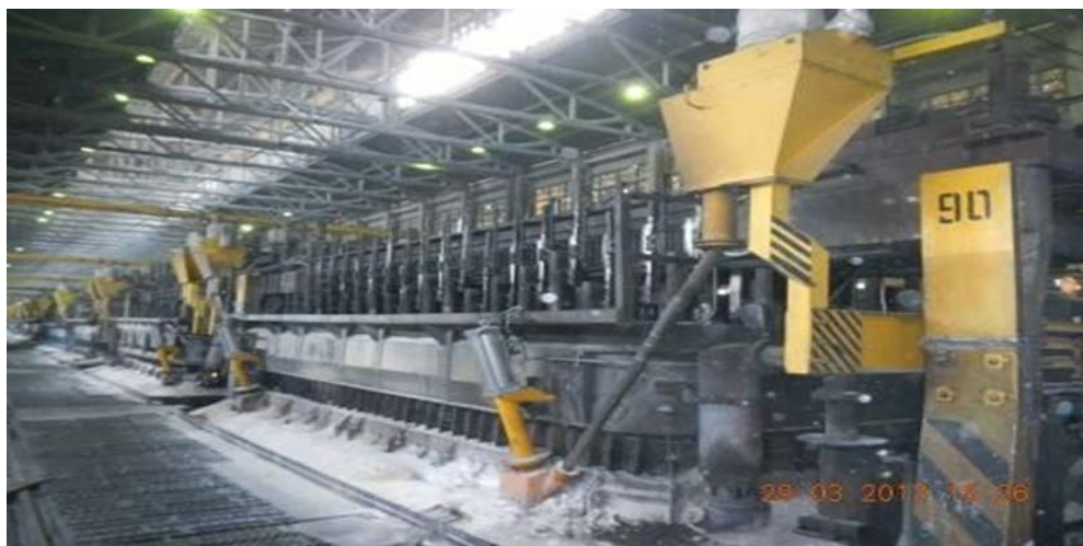
рис.1 Электролизёр С-8 БМ(Э), оснащённый системой АПС
