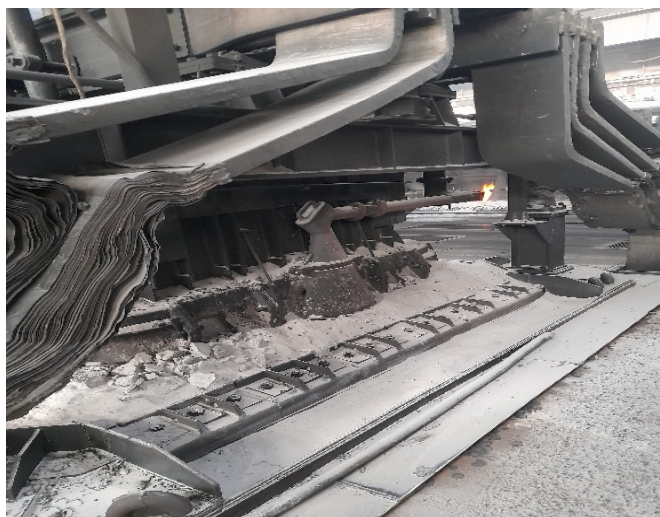
рис.2 Электролизер С-2(Э), С-3(Э) торцевая сторона
