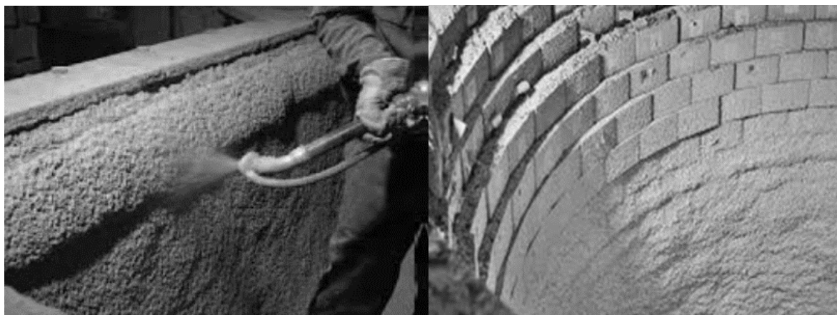
рис. 1 Торкретирование разливочных ковшей [7]
